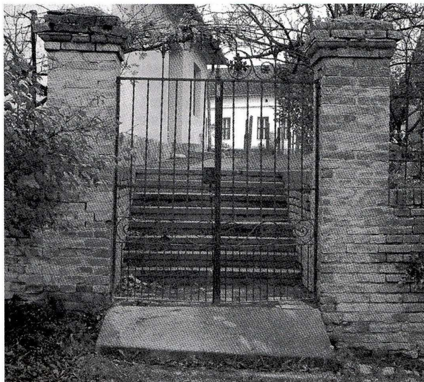
Az egykori épület korácsolvas kerítése és kapuja
